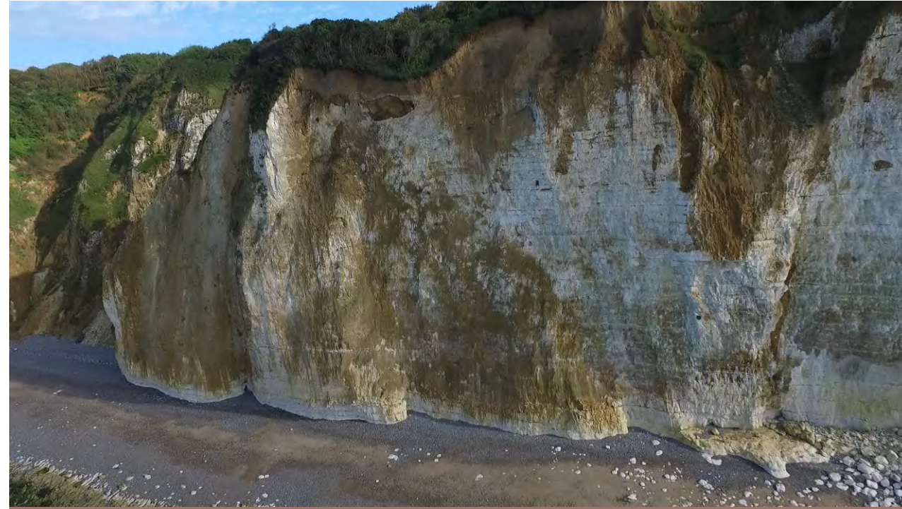
Suivi du front de falaise par drone à Varengeville-sur-Mer (21/06/2016, Grandjean et Ammann)
