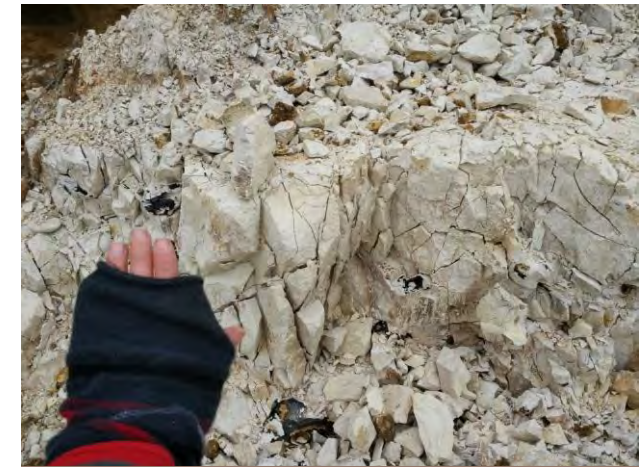
Chutes de pierres (éboulisation) à Varengeville-sur-Mer (25/01/2017, Letortu)
